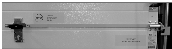
Рис. 42. Установка запирающего устройства. Вид изнутри
